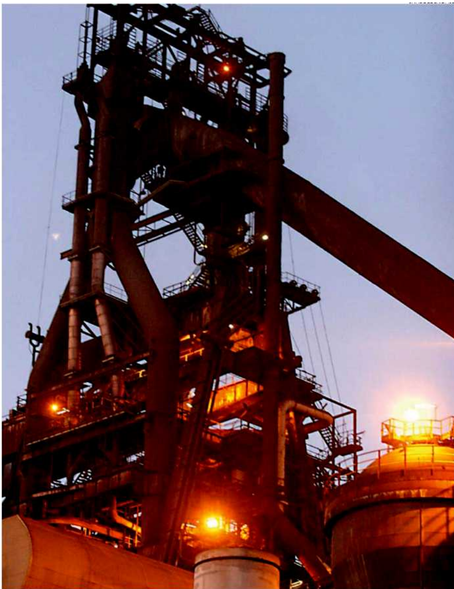
Il nodo di Taranto. L'impianto siderurgico dell'Ilva di Taranto è una delle emergenze nazionali da affrontare anche in termini di bonifica dell'area
