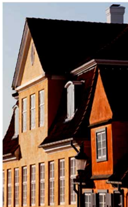
Strategie di difesa. Due immagini del Fæstningens Materialgård, il deposito di materiali bellici del 1600 ristrutturato a Copenhagen in maniera sostenibile, preservandone le linee
